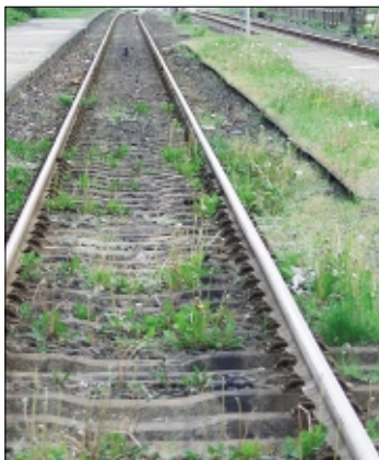
Wegen Gleisbauarbeiten sperrt die Bahn die Strecke zwischen Soltau und Schneverdingen.
